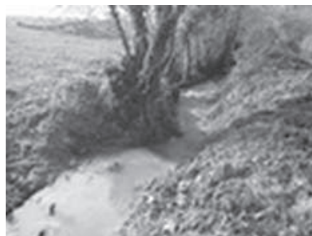
APRES : Le passage busé a été retiré, les continuités écologiques sont rétablies ainsi que le bon écoulement de l'eau.
